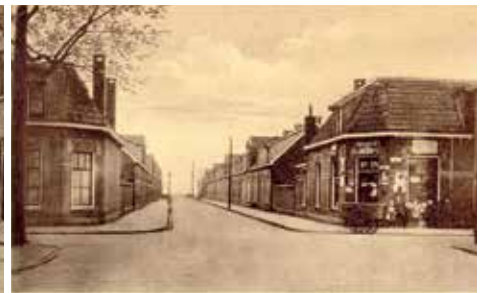
Sumatrastraat met hoek Riouwstraat Collectie Historisch Centrum Overijssel (1935)
